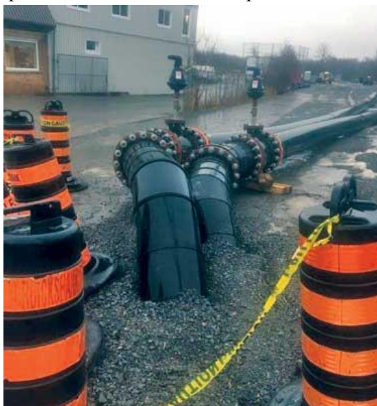
Точка заглубления сдвоенного трубопровода для прохождения под дорогой
